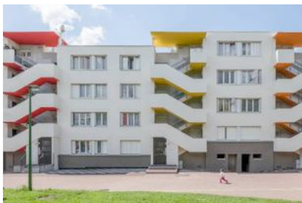
Bâtiments bas après réhabilitation
