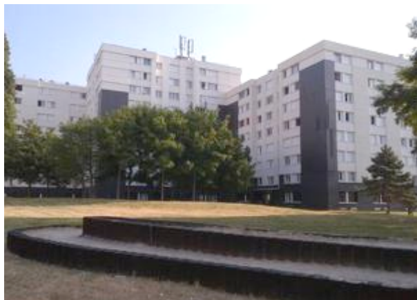
Tours après réhabilitation
