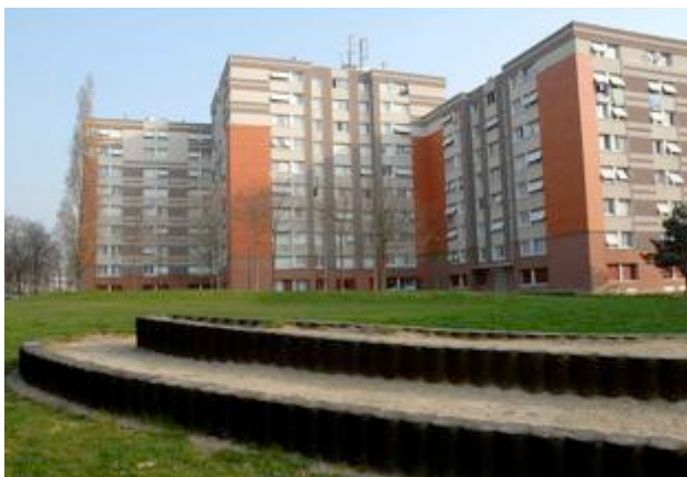
Tours avant réhabilitation
