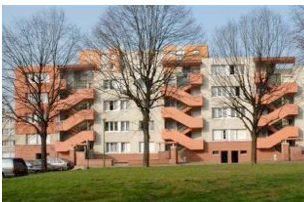
Bâtiments bas avant réhabilitation
