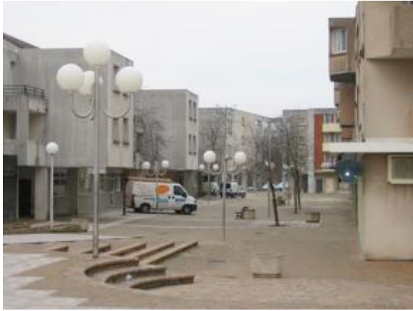
Rue Georges Brassens avant démolition
