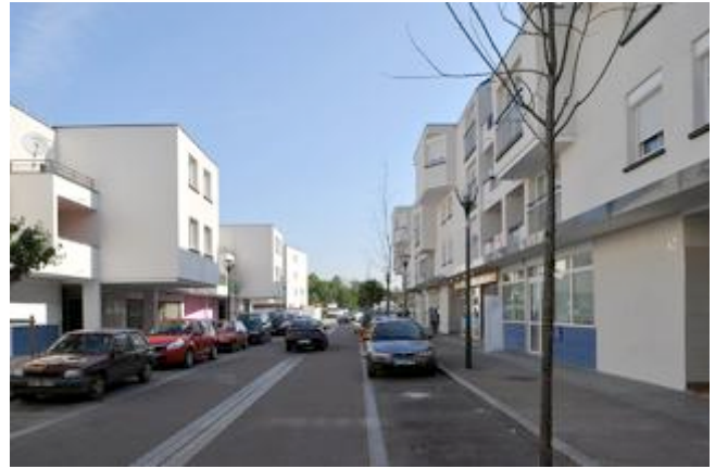
Rue Georges Brassens après démolition
